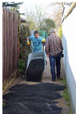
.....während der Reinigung und Sanierung.....
