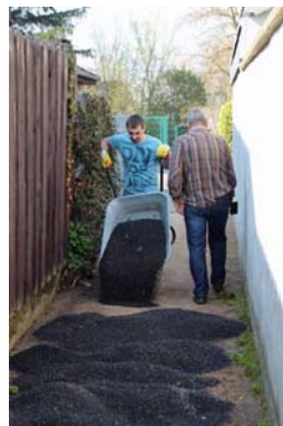
.....während der Reinigung und Sanierung.....
