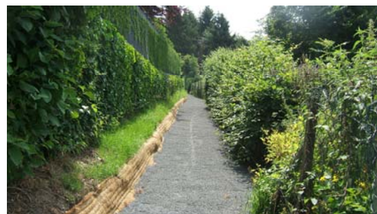
Nach der Renovierung
